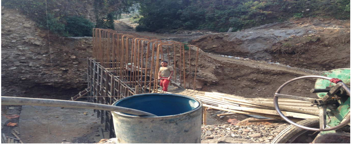
(मुसीकोट चौरजहारी खण्डस्थित छिवाड खोलामा Diwa Dragan JV द्वारा निर्माणाधिन पूलको अवस्था, २०७१ फागुन ५ )
